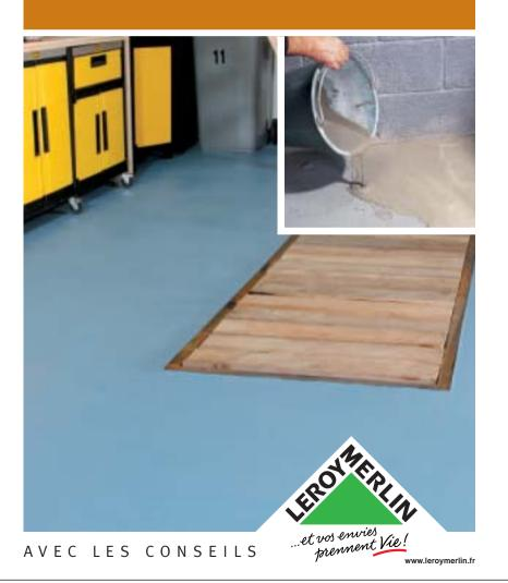
Les enduits de ragréage autolissants permettent de rattraper les inégalités d'un sol, qu'il soit cimenté, carrelé ou parqueté, avant la pose d'un nouveau revêtement. Ils forment une couche de quelques millimètres d'épaisseur (10 maximum) ou certains 30 mm s'ils sont fibrés. Si les inégalités sont supérieures, prévoir du mortier.
