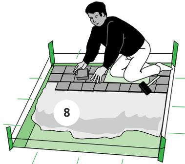
9 Contrôler l'alignement des pavés au fur et à mesure de l'avancement avec un niveau à bulle placé sur une règle plate.
